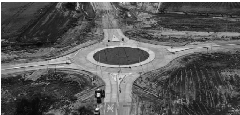
Pavimentamos el acceso a Colonia Videla
