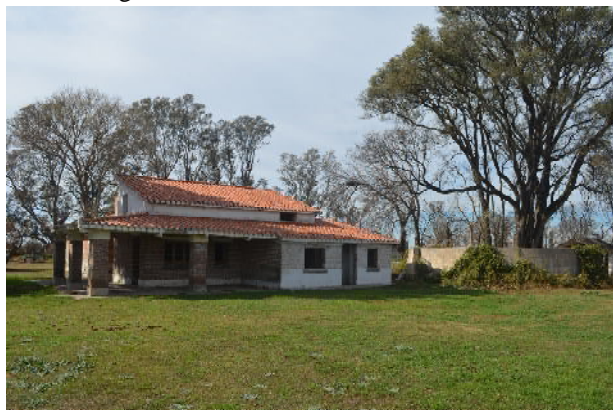
Casa del fundador que está siendo puesta en valor
