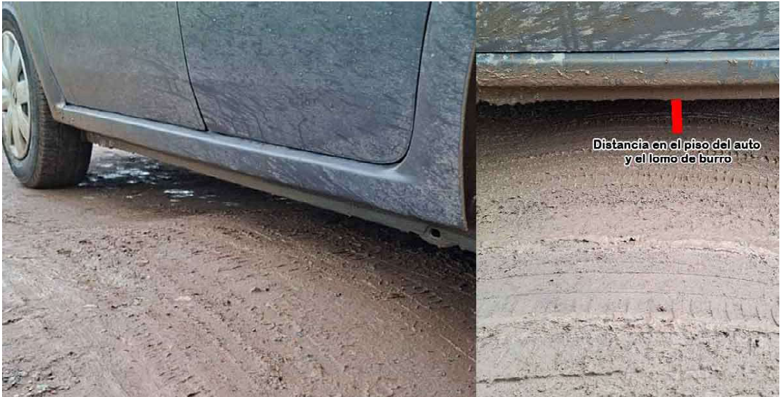
Lomo de burro en la que es necesario reducir la velocidad casi a cero para evitar golpear el auto. En la mayoría de los casos se tratan de montículos de tierra que obstaculizan la circulación en lugar de ser reductores.
