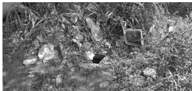
Pozo en el que descargan los líquidos cloacales los tanques atmosférico, donde además caerían bolsas con basura
