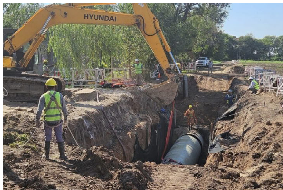
Las primeras excavaciones y colocación de caños en Coronda
