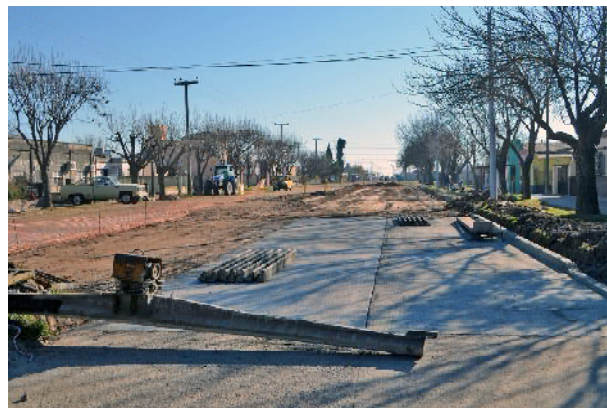
Pavimentación en el sector noroeste
