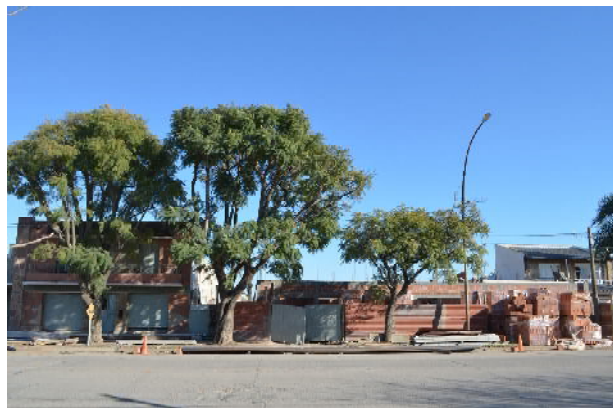
Construcción edificio escuela formación profesional
